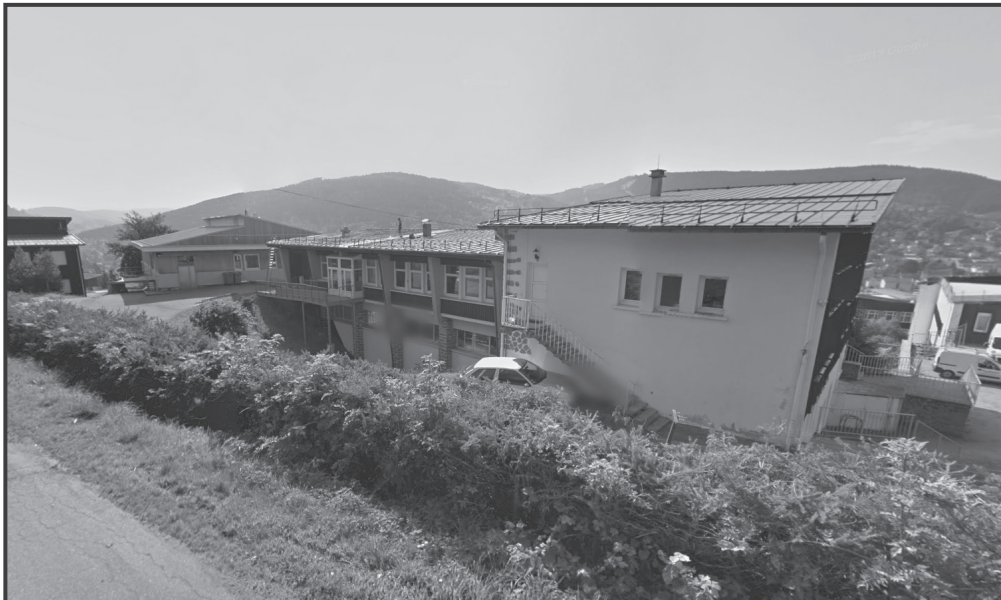
L'internat et le pôle espoir de La Haie-Griselle n'ont pas été épargnés par la tornade qui a sévi.
